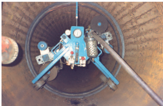
Limpeza rotativa das zonas de contacto com a junta a aplicar
