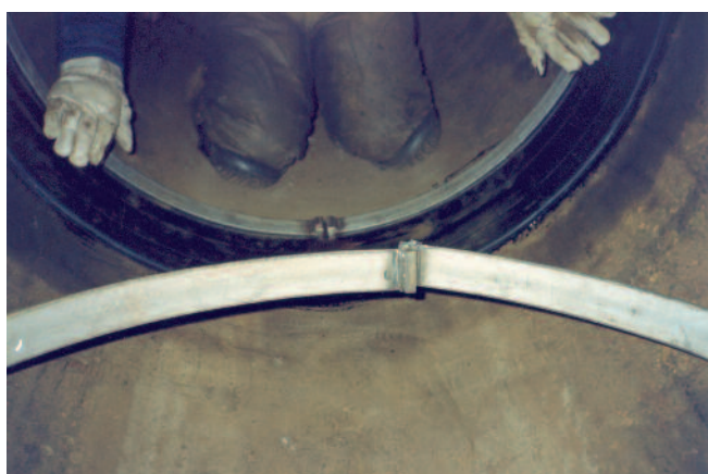
Aplicação de 2 anéis de aperto
